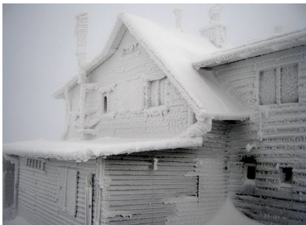
Budynek obserwatorium meteorologicznego na szczycie.
